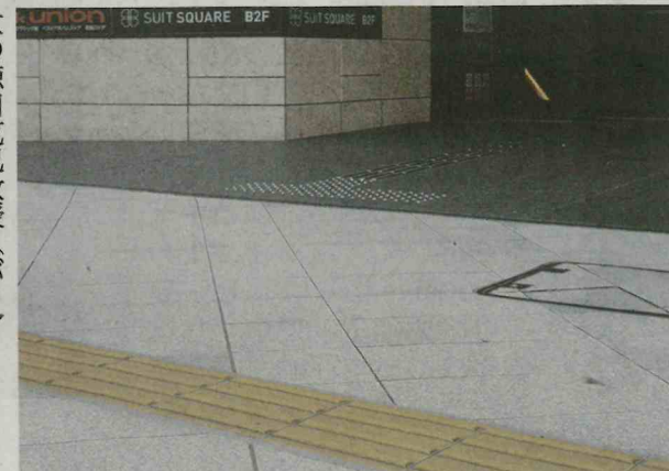
歩道の線状の点字ブロック(手前)は、地下道へ続く点状の点字ブロック(奥)につながらない＝東京都新宿区で
